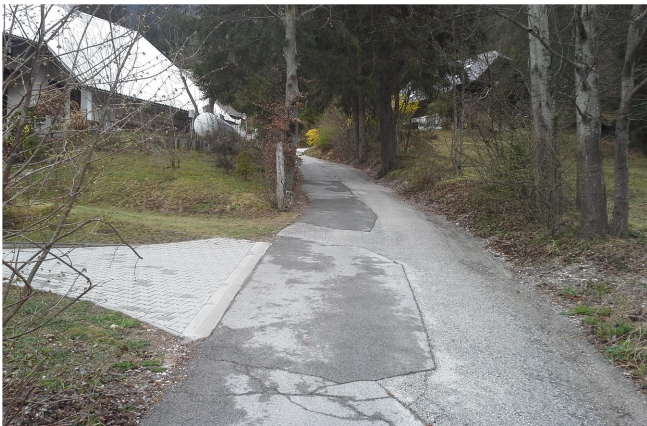
Slika 3: Pogled na Kurirsko pot med P5 in P7 z uvozom do stanovanjske hiše Kurirska pot 6
