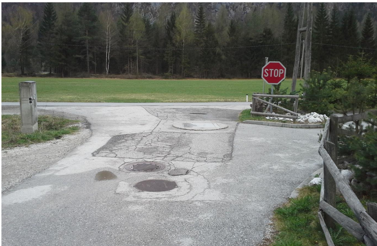
Slika 1: Pogled na priključek Kurirske poti na državno cesto s črpališčem kanalizacije in el. omarico
